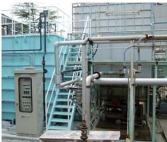
浸漬平膜浄化装置
