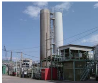
深層型曝気槽と汚泥乾燥設備
