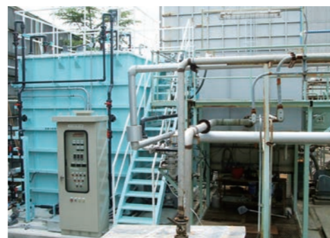
浸漬平膜浄化装置
