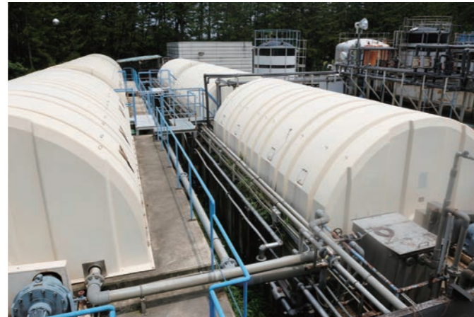
回転円盤排水浄化装置
