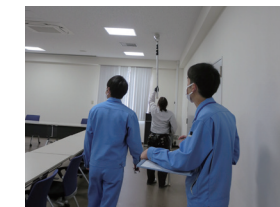
消防設備点検のようす
