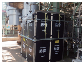
簡易防音壁の設置
